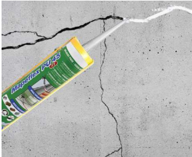
Sellado de fisuras con masilla de poliuretano, acética o híbrida
