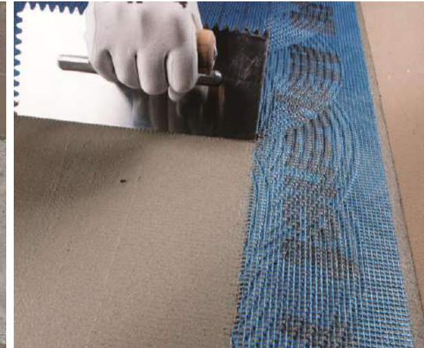
Armado de membrana impermeable con malla Mapenet 150
