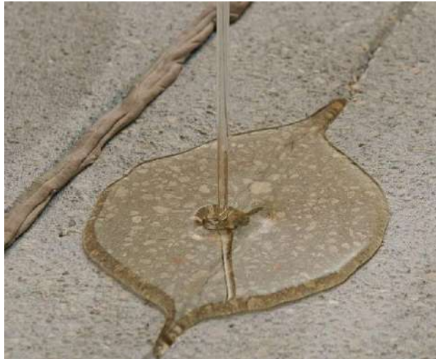
Relleno de fisuras por vertido con resina epoxi Epojet
