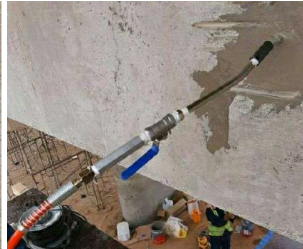
Inyección de fisuras con resina epoxi Epojet
