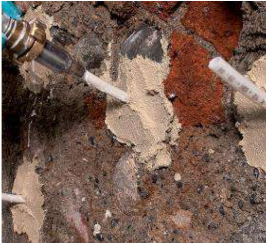
Sellado de fisuras con morteros de cal Mape-Antique I
