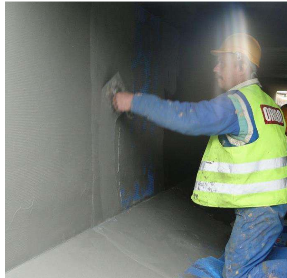
Fig. 1: Protección con Mapelastic de una fisura en el intradós de una viga de hormigón sometida a una tensión por flexión
