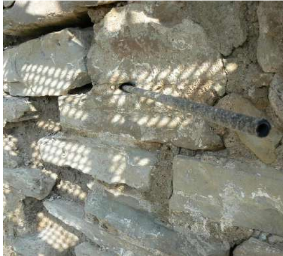
Cosido con varillas de fibra y lechada de cal Mape-Antique I y Maperod
