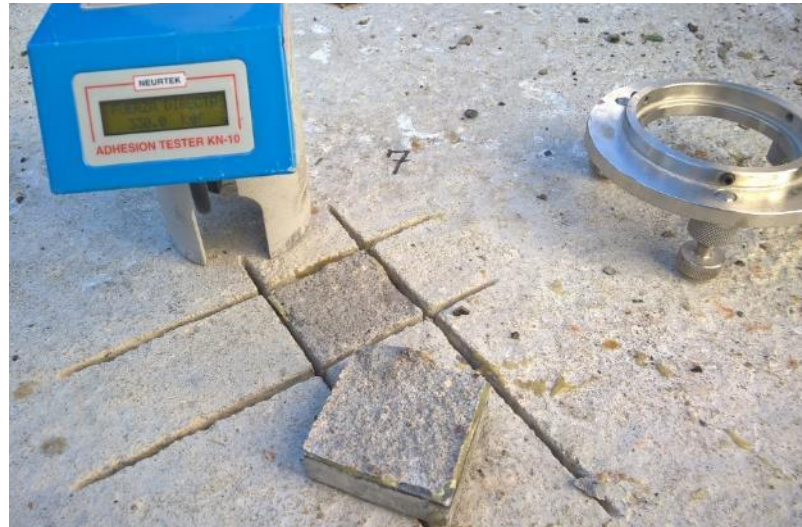
Ensayo pull off para determinar la resistencia a tracción del hormigón
