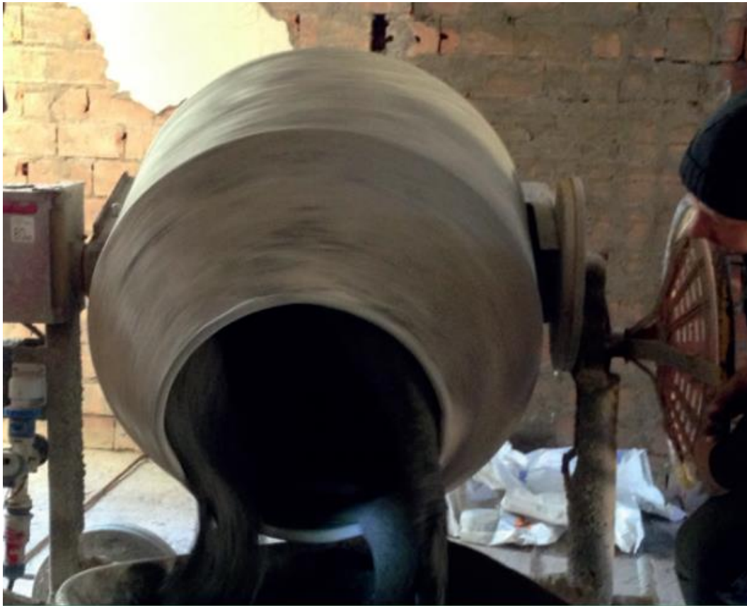
3.- Amasado en hormigonera de tres palas
