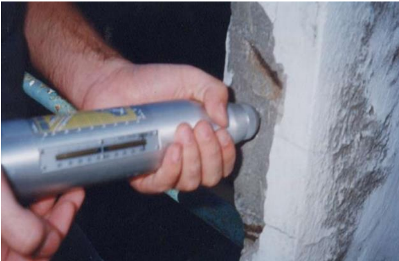
Ensayo con esclerómetro para determinar la resistencia a compresión del hormigón
