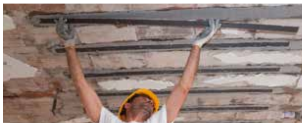
Aplicación de CARBOPLATE SYSTEM sobre viguetas de forjado de bovedilla cerámica y viguetas de hormigón
