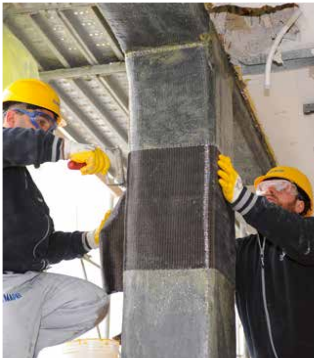
Refuerzo de un nudo viga-pilar con MAPEWRAP C SYSTEM
