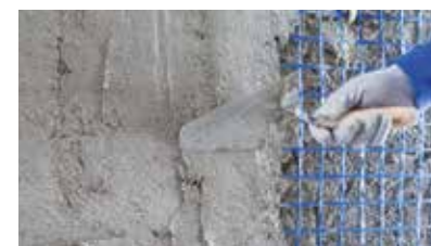
Aplicación del refuerzo para incrementar la resistencia a cortante, a tracción y a compresión
