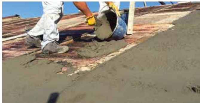
Refuerzo de forjados de cubierta inclinados
