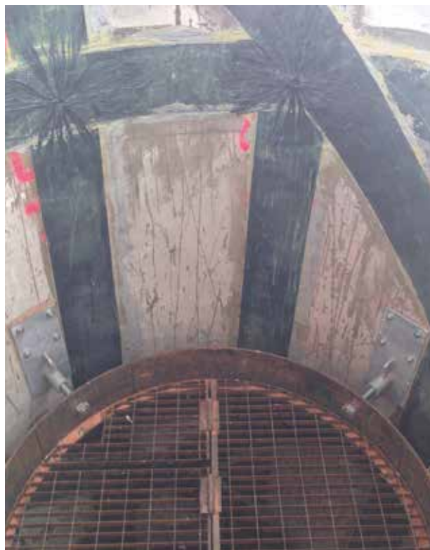
Refuerzo de chimenea de ladrillos con MAPEWRAP C SYSTEM
