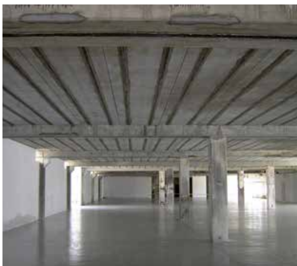
Refuerzo a flexión de vigas y forjados con CARBOPLATE SYSTEM
