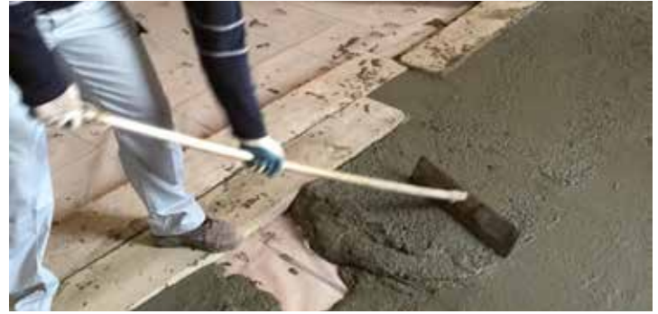
Refuerzo del trasdós de forjados de madera
