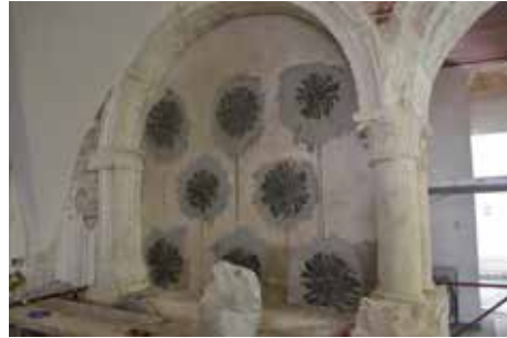
Conexión mecánica adicional con "fioccos" de fibra de carbono
