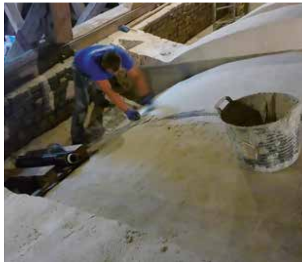
Refuerzo del trasdós de bóvedas de albañilería
