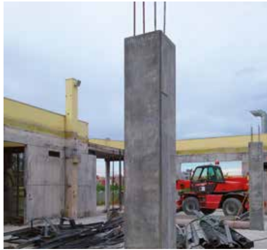
Refuerzo de pilares mediante encamisado de bajo espesor
