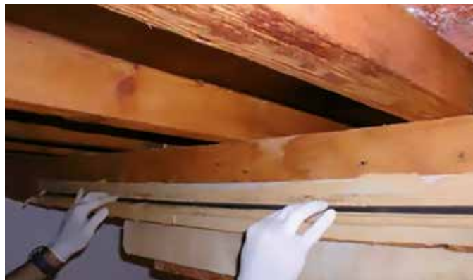
Refuerzo de vigas de madera con MAPEROD SYSTEM
