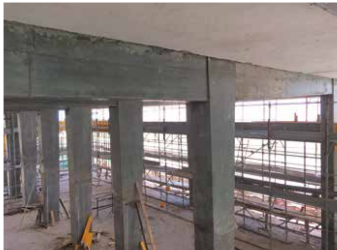
Refuerzo de vigas y pilares mediante encamisado de bajo espesor
