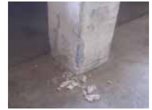
Rotura a flexocompresión
